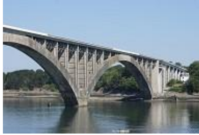
Pont de Plougastel
